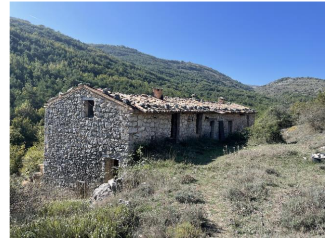
Maison de Berdine à Le Broc, France
